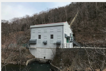
発電所建屋外観(第三発電所)
