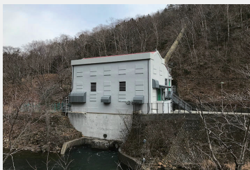
発電所建屋外観（第三発電所）
