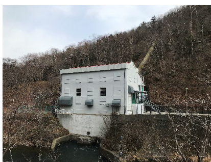
発電所建屋外観(第三発電所)
