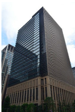
三井住友ファイナンス&リース東京本社 (三井住友銀行 東館)
