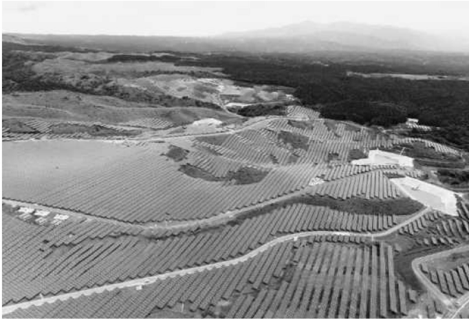
22年9月に商業運転を始めたJRE山都高森第一太陽光発電所（熊本県山都町）
